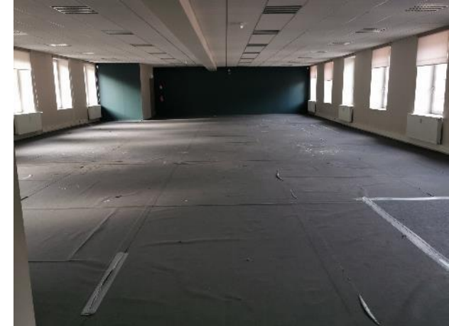
Le niveau 3 libre de cloisons
